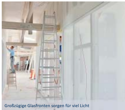
Das zukünftige Großraumbüro von DMB im 3. Obergeschoss
