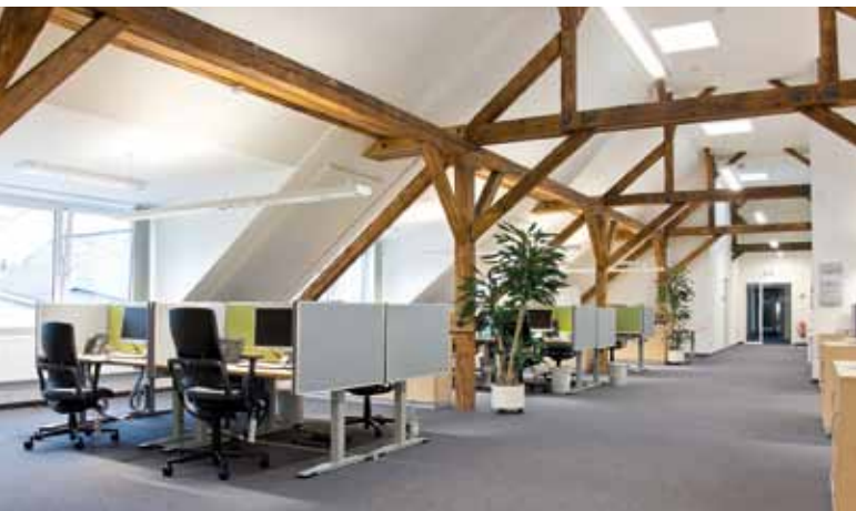
Bei der Sanierung des Gebäudes 7c werden ebenso großzügige Gauben eingerichtet wie hier im 8. Bauabschnitt. Foto: schönherr.fabrik
