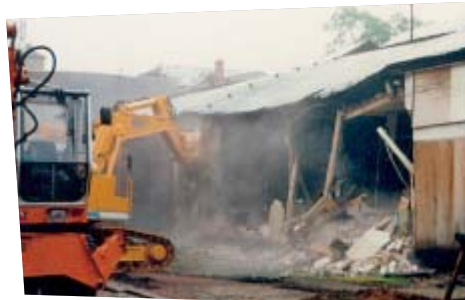
Abriss von maroden Gebäuden
