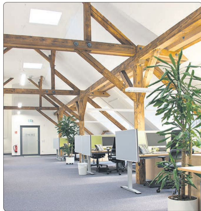
Wie hier bereits realisiert, werden auch im Dachgeschoss des letzten Bauabschnittes großzügige Gauben eingebaut, damit der Raum den Anforderungen einer natürlichen Belichtung für eine Büronutzung gerecht wird. Foto: WEBA
